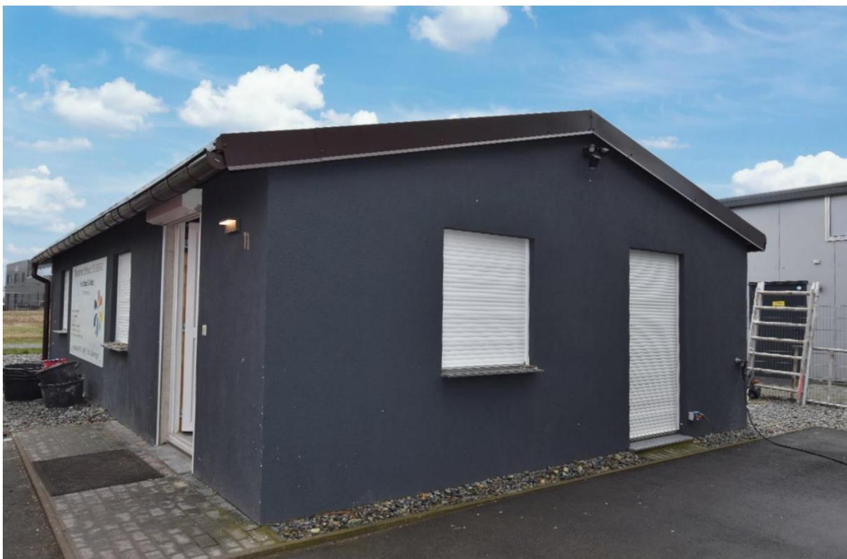
Gebäude aus Stahlbeton-Fertigteilen, gedämmt und für Fußbodenheizung vorbereitet
