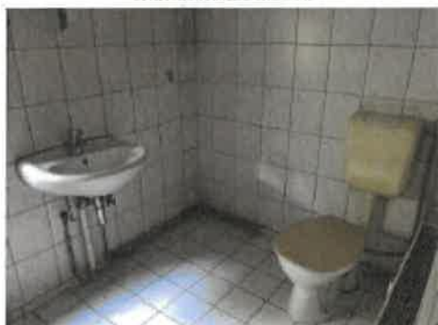
Toilette und Bad
