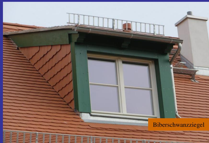
Die Dachdeckung der Häuser mit Biberschwanzziegeln wurde in den vergangenen Jahren bereist denkmalgerecht erneuert. Diese Deckung bleibt teilweise bestehen und wird in zu verändernden Bereichen umgedeckt bzw. ergänzt. Eine komplette Erneuerung aus konstruktiver Notwendigkeit und in Abstimmung mit dem Denkmalamt bleibt vorbehalten.
