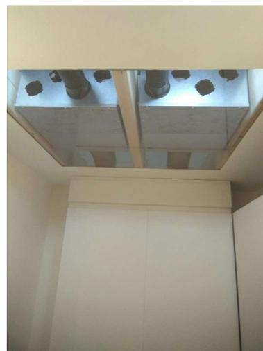
Die Installation der Luftverteiler oberhalb des Lüftungsgerätes erfolgt unsichtbar in der Decke, welche in diesem Bereich um ca. 18 cm abgehängt wird. Damit wird der Aufstellraum des Lüftungsgerätes frei für weitere anspruchsvolle Nutzungen. Im Lüftungsgerät und in den Luftverteilern sind wirkungsvolle Schalldämpfer integriert.
