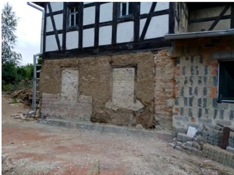
Ostseite / Seitenflügel /Anbau, die ehemalige Steinmauer vor der Lehmwand / Bohlenstube im EG ist bereits beseitigt. Beide Fenster zugemauert.
