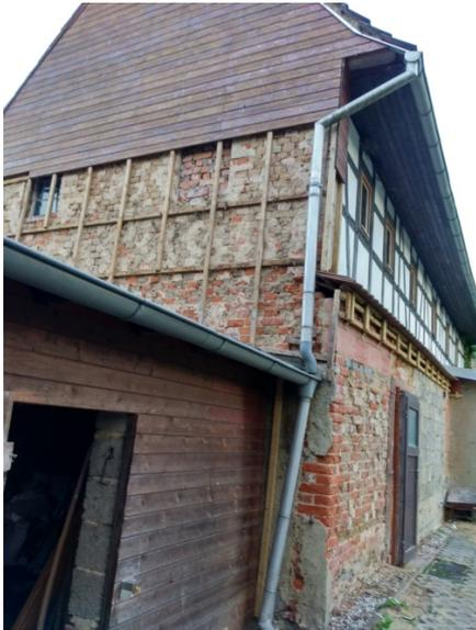
Nordseite / Giebel, komplett mit Holz verkleidet, keinerlei Fenster. Im OG links/Ostseite ein mit Brettern verdecktes, einfach verglastes, verrottetes Fenster.
