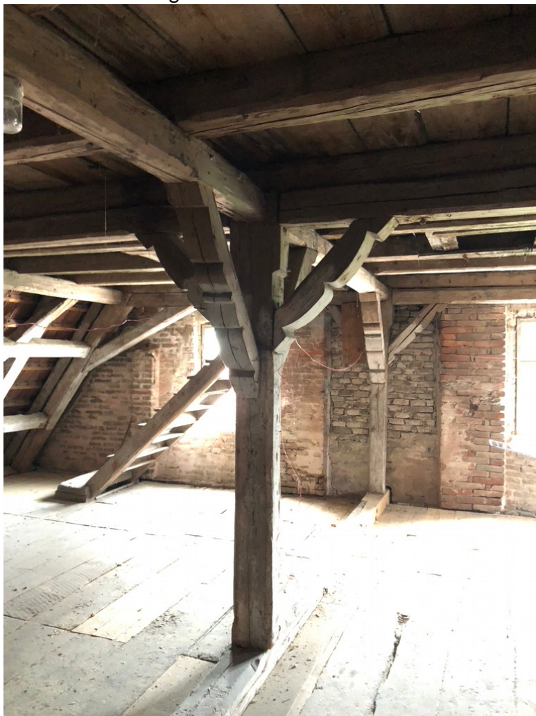
Unausgebauter Dachraum im 1. DG
