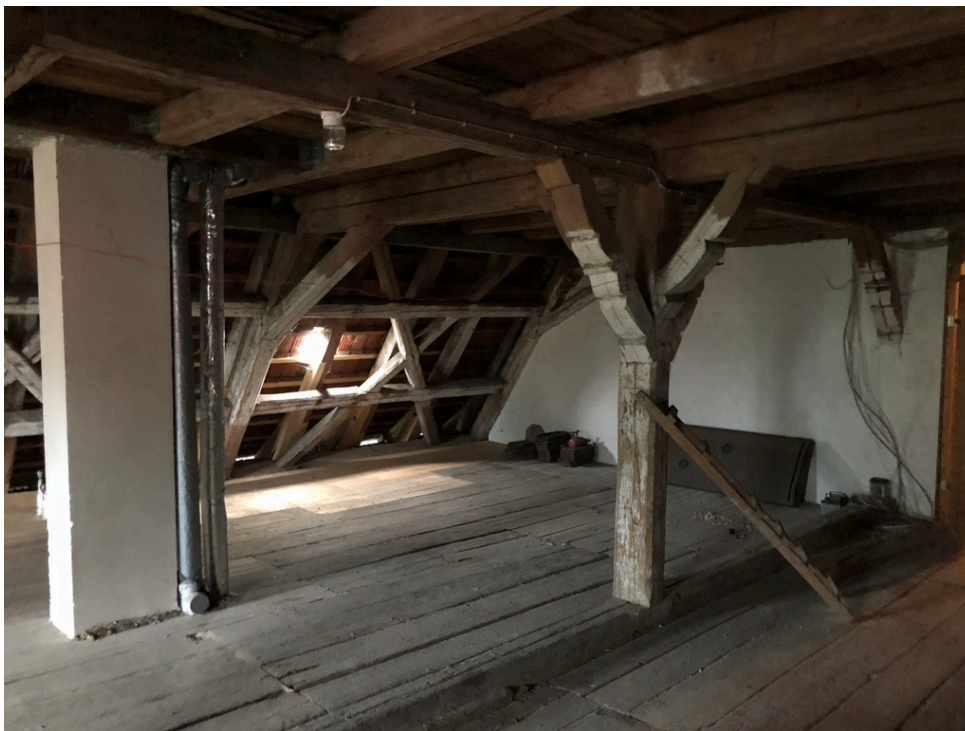
Unausgebauter Dachraum im 1. DG Leistungsführungen sind bereits vorhanden
