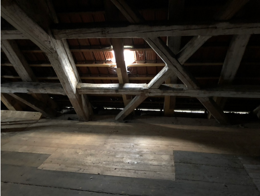
Unausgebauter Dachraum im 1. DG
