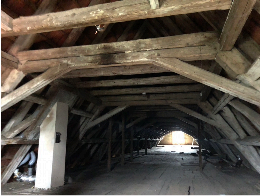
Unausgebauter Dachraum im 2. DG
