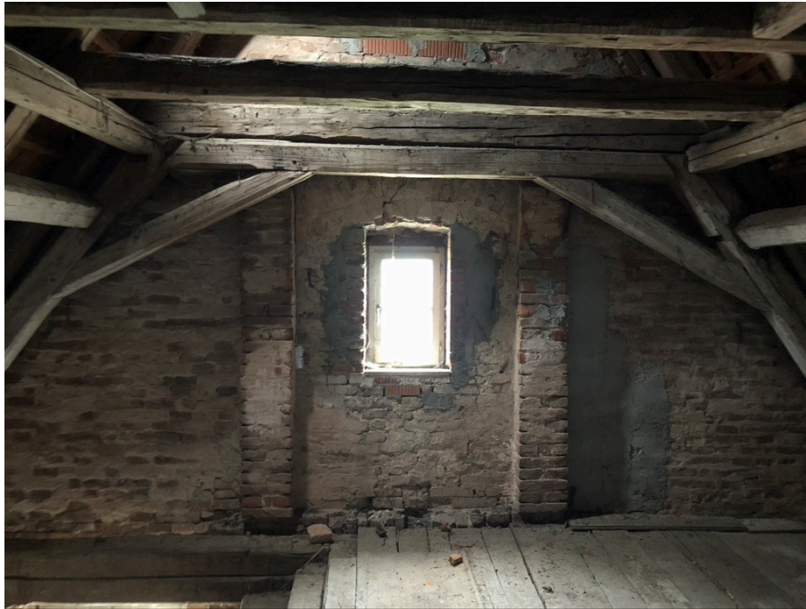
Unausgebauter Dachraum im 1. DG
