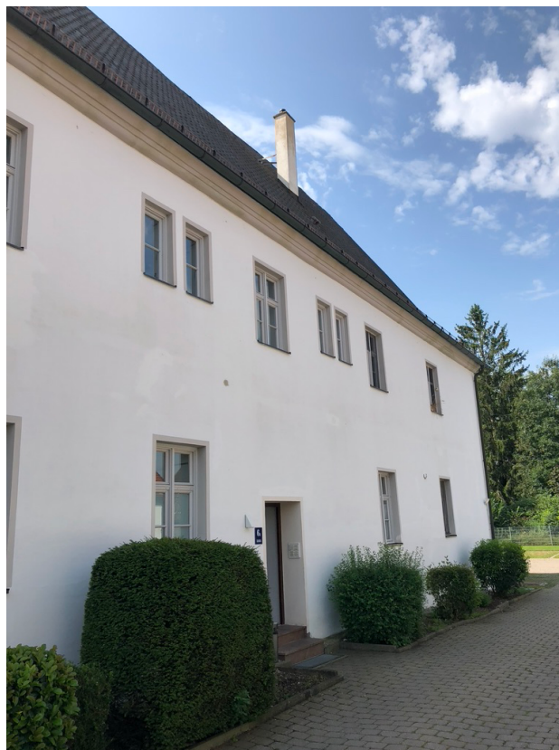
Nebengebäude / Nord Ansicht
